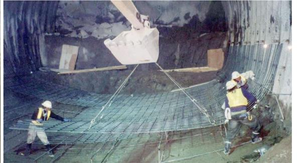
①補強鉄筋をあらかじめ工場にて格子状に製作することにより、現場での配筋組立作業が大幅に軽減され、省力化及び作業時間の短縮となる。
